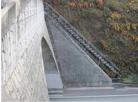
시점부 옹벽 상태양호
