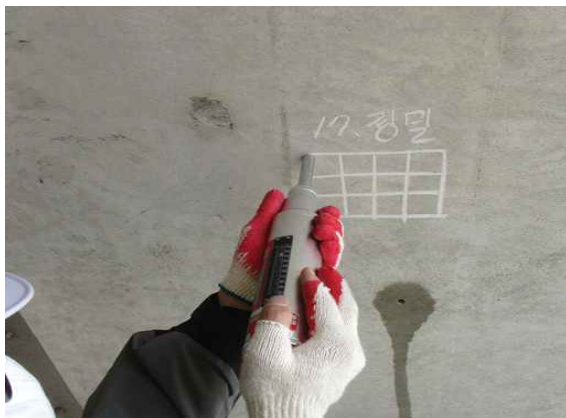
반발경도 측정 현황(측벽부)①
