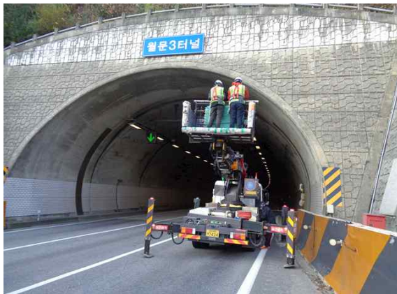
고소작업차를 이용한 외관조사 현황①
