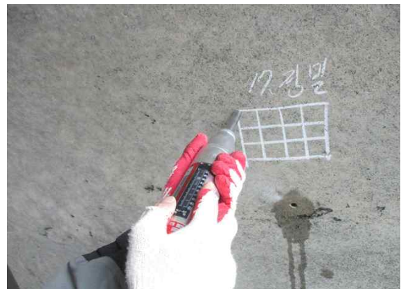
반발경도 측정 현황(측벽부)②
