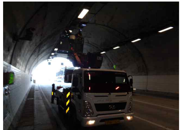
고소작업차를 이용한 외관조사 현황②
