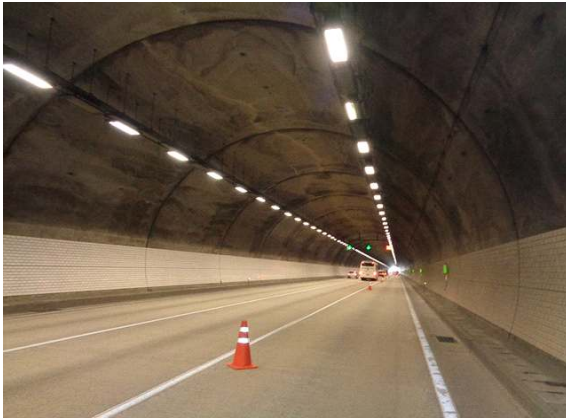
콘크리트 라이닝 전경
