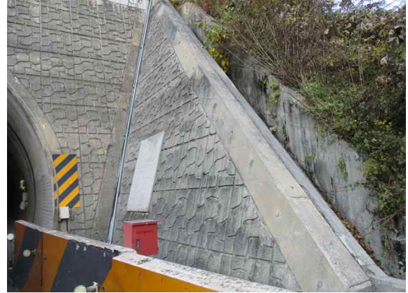
종점부 옹벽 상태양호
